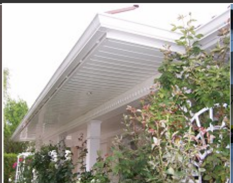
Débords de toiture
